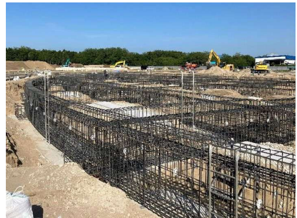
図11 外周部基礎梁配筋状況
