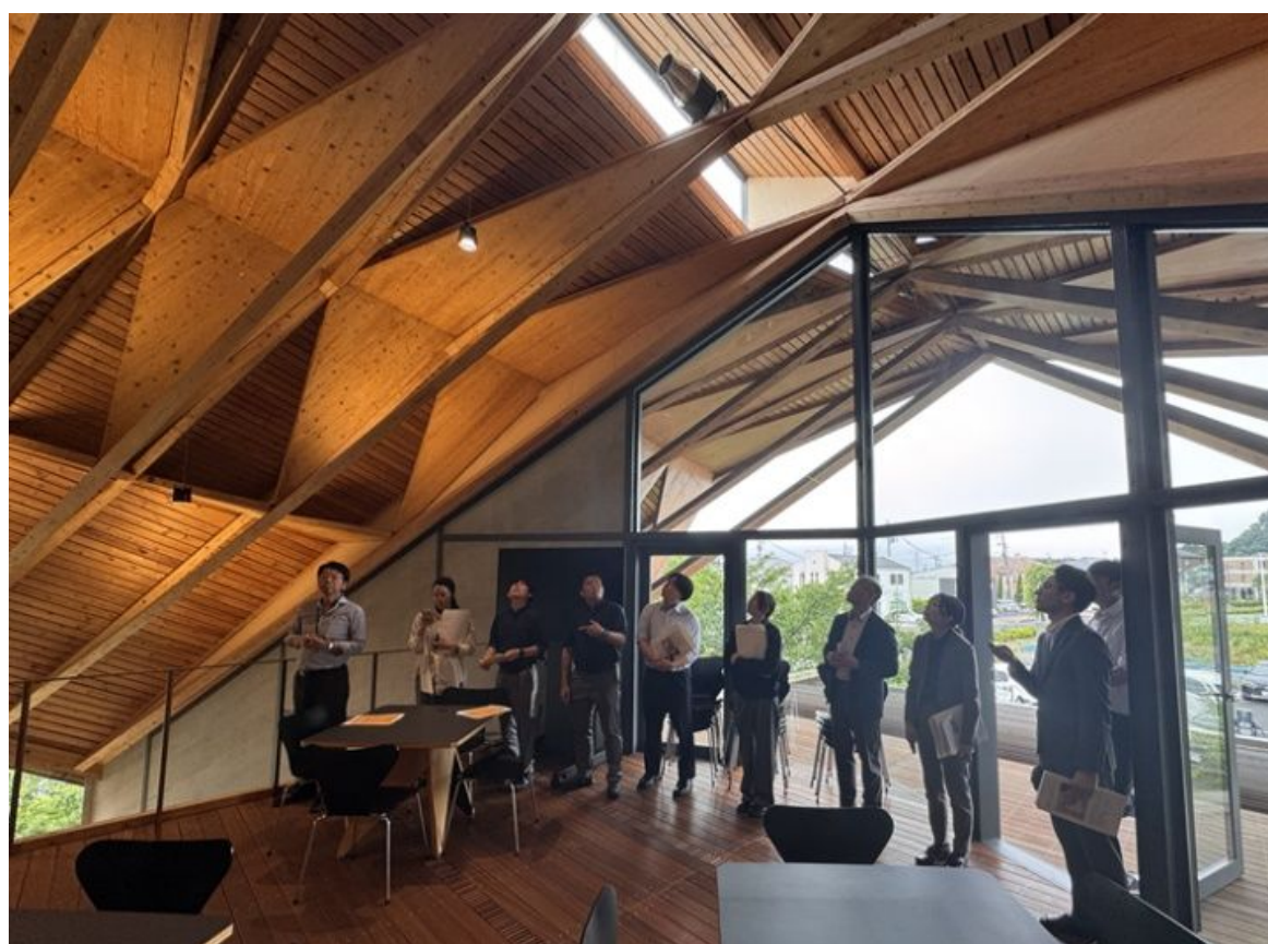
集成材トラス梁・CLT パネル接合部説明状況
