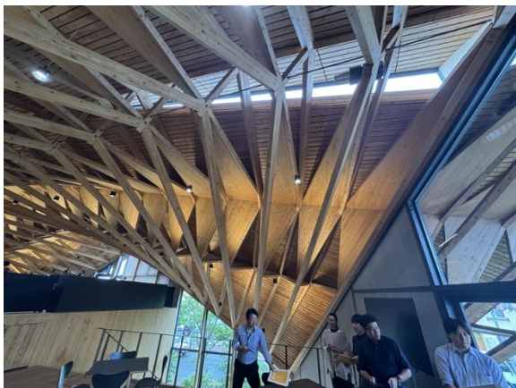
エントランス上部
