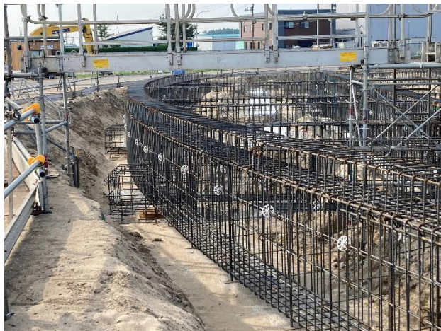
図11 外周部基礎梁配筋状況
