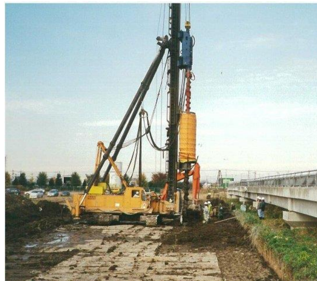
深層混合処理工法
