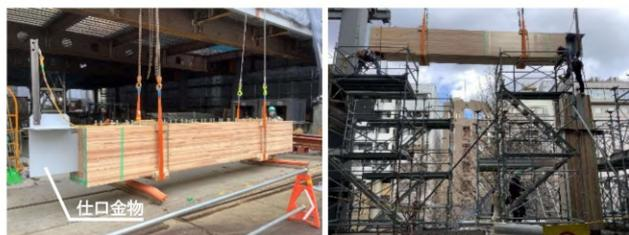
燃エンウッド®梁の揚重 燃エンウッド®梁の落とし込み
