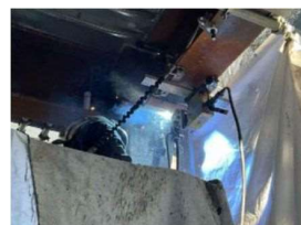
ロボット溶接施工写真
