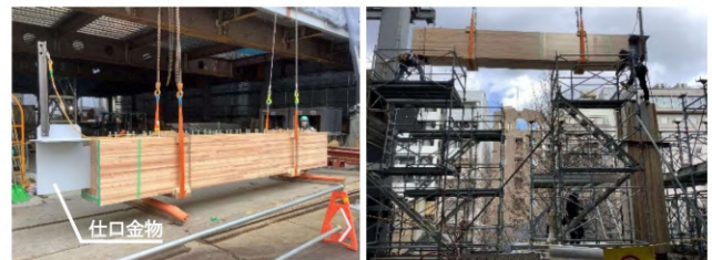
燃エンウッド®梁の揚重
