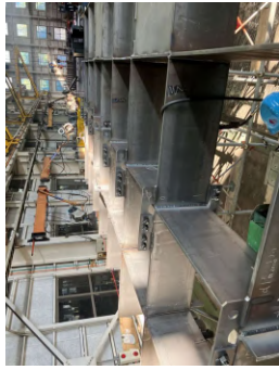
4ユニット接合時の状況写真
