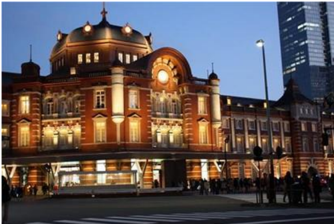
東京駅駅舎：現存 (2010年の改修工事木杭撤去)
