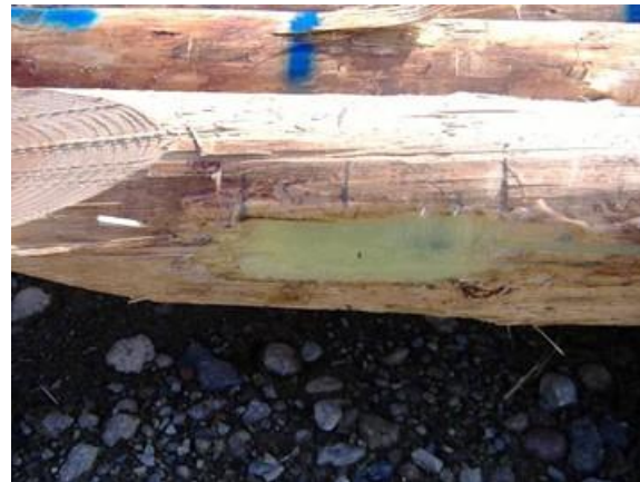
センサ（歪ゲージ）貼り付け状況
