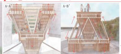
木造トラスと格子の引張力で、上部の迫持式構造の跳ね上がる力と下部の迫持式構造の沈み込む力を支える。 主となる「3本の軸」がある
