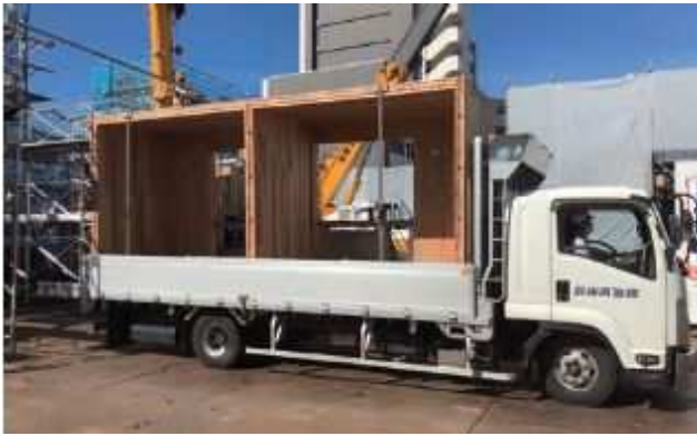
図5 CLTユニット運搬状況
