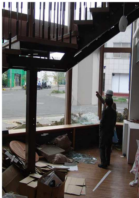
調査状況（建物所有者への説明）
