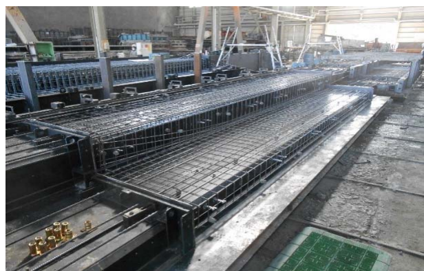
段床 配筋・配線状況
