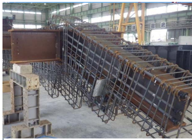
レイカー梁 配筋状況
