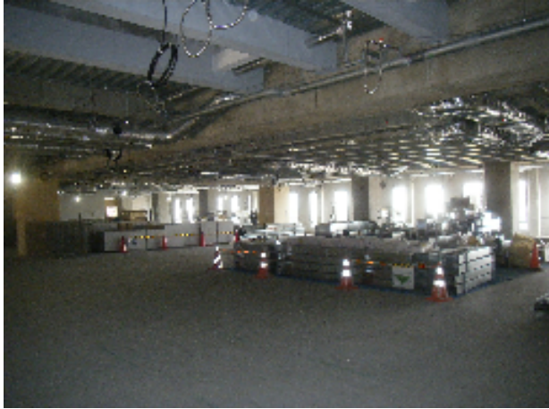
圧巻の大空間 建物中央部でこの廻りがSRC造
